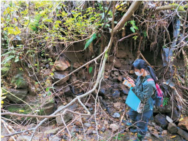
図12 耕作地跡がある斜面を保護する石垣の崩壊
