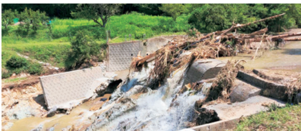
図13 淳上川からの流木が堰堤に捕捉されている様子
