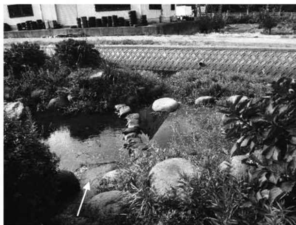
図 26. 安産川親水公園のバイパス水路側と本川側を仕切る土のう（白色矢印はやすまる銘水の流下地点）
